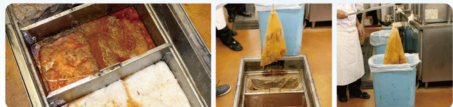
オイルホールドは、触れている油を約 15 分程度で自然に 2kg 以上吸収します。予めオイルホールドをグリストラップに敷き詰めておけば、後は勝手に油を吸収します。(一部残った油は、なでるようにして吸収させてください。)
