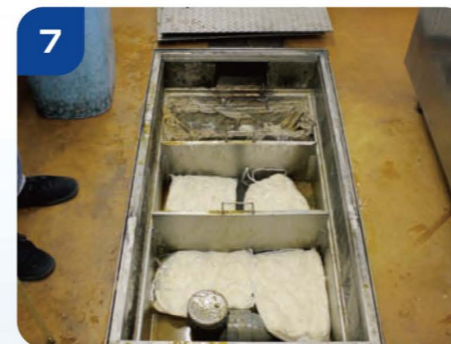
7 作業が終了したら、新しいオイルホールドを敷き詰めます。
