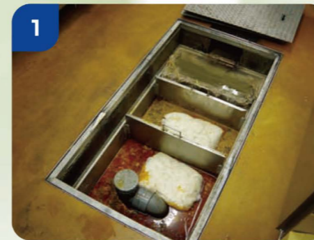
1 オイルホールドをそのままグリストラップの油槽に投入してください。(水は吸わないので沈みません。)
